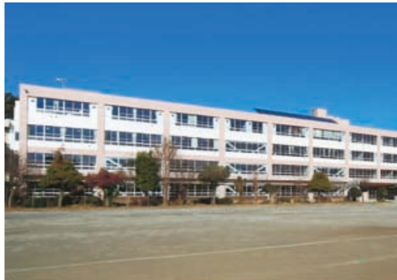
耐震補強工事が完了した北本中学校の校舎
