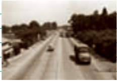
国道17号が開通(昭和37年)※
