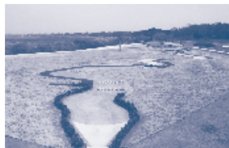
▲旧河川を模したせせらぎ水路
